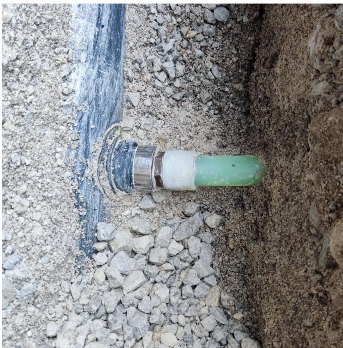
Slika izvedbe spoja med kolektorjem in stransko cevjo
